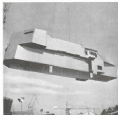
Substruttura, per il montaggio a Stabia, di un fianco di ferro struttura di m. 20 x 8 e del peso di 8 tonnellate, destinato in costruzione per la Marina Militare Italiana.
