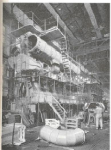
Grandi motori Diesel in montaggio. In primo piano un motore Ansaldo - Fiat tipo 11F 5 destinato alla motonave panamense «Las Minas» e in secondo piano un motore Ansaldo - Bedford tipo 67 LB 5 destinato alla motonave panamense «Normanna».
