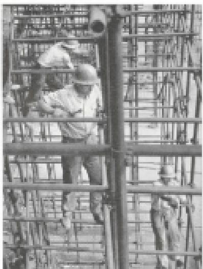
Posteggiatori di lavoro per il montaggio di una impalcatura sotto le prove di una nave in costruzione. Gli operai posteggiatori, a bordo gli operai di altro sport, sono stati equipaggiati recentemente al Cantiere di Stabia con elmetti di protezione «ENP», caschi d'ombrello e caschi di corpi cadenti.
